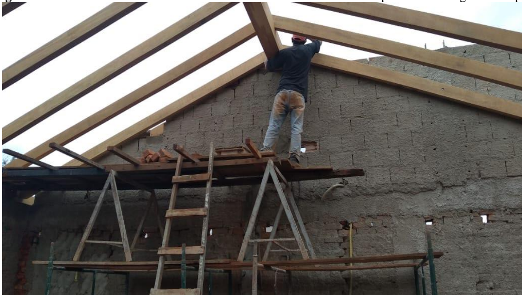
Figura 3 – Colaborador trabalhando em altura sem EPI e com andaime improvisado sem guarda corpo.
