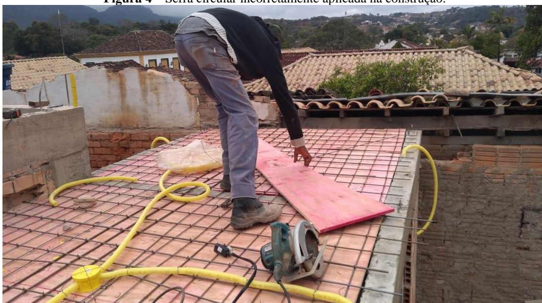
Figura 4 – Serra circular incorretamente aplicada na construção.
