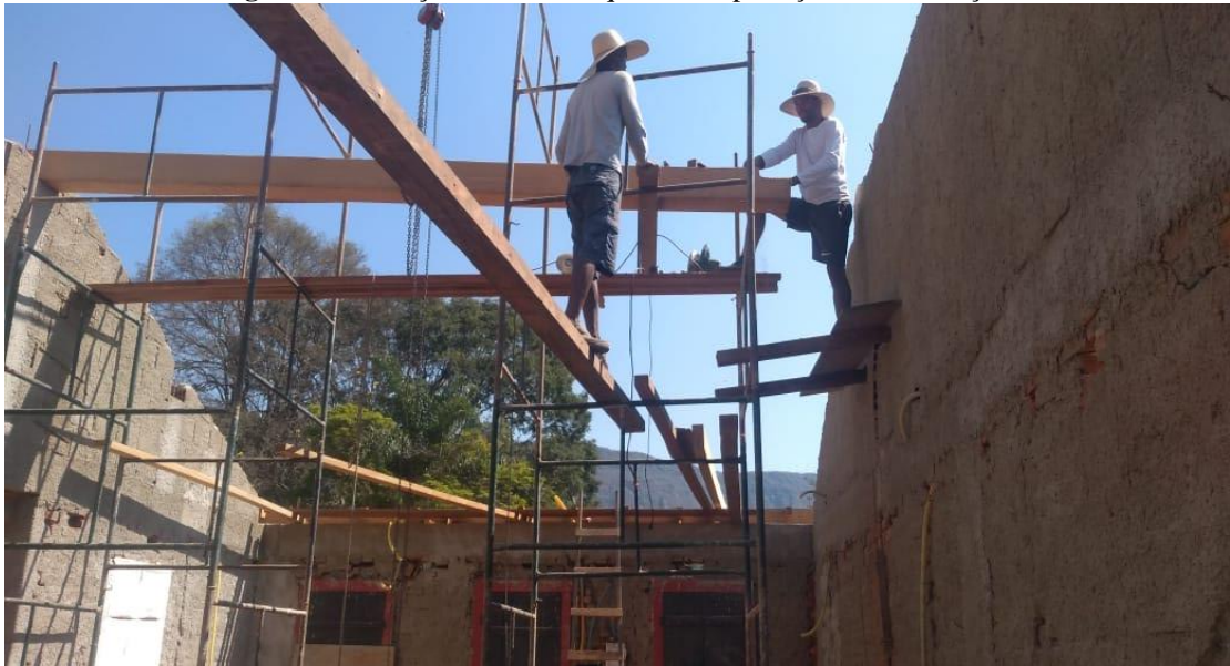
Figura 2 – Situação de risco de queda sem proteção ou sinalização.
